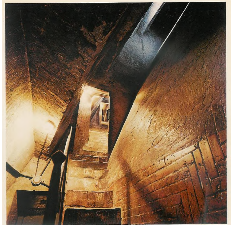
Fig. 7 Il camminamento fra la cupola interna (a destra) e quella esterna (a sinistra)
